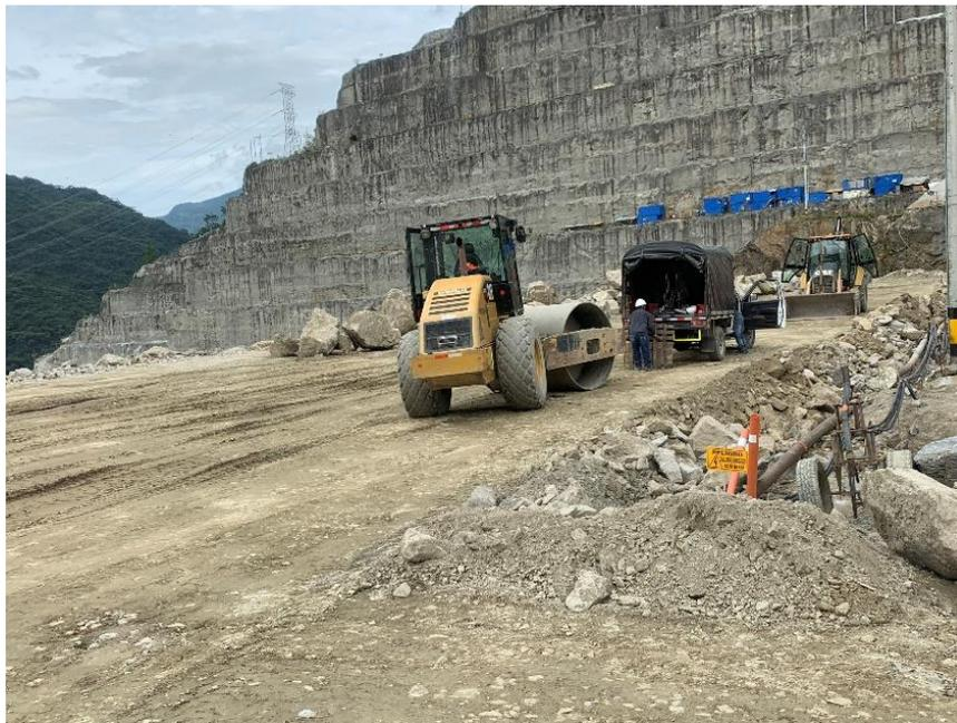
*Foto 94. Rodillo compactando el piso del muro de Hidroituango en el sector contiguo al Vertedero (Foto: Modesto Portilla Gamboa)*
