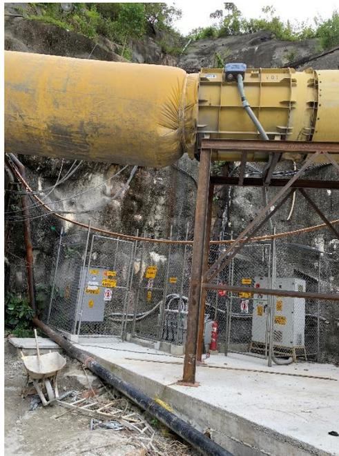
*Foto 117. Ductos de ventilación en el portal de salida del túnel de acceso al muro desde El Valle de Toledo (Foto: Modesto Portilla Gamboa)*
