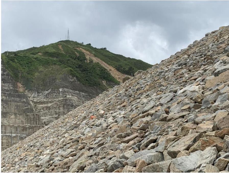
*Foto 102. Cara enrocada del espaldón del muro aguas abajo (Foto: Modesto Portilla Gamboa)*
