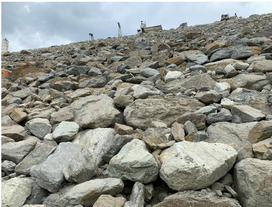
*Foto 103. Bloques de gneis que recubren el espaldón del muro aguas abajo (Foto: Modesto Portilla Gamboa)*
