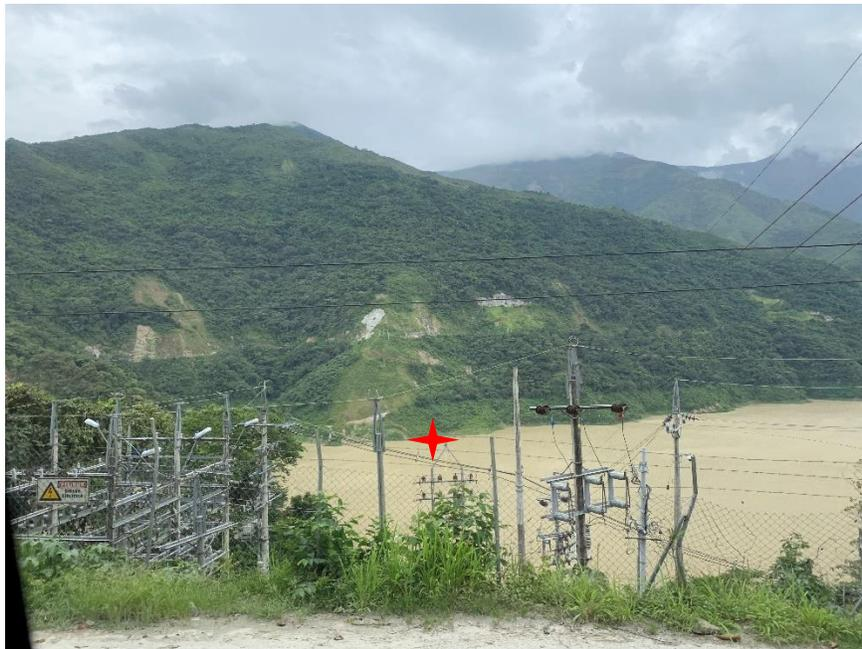
*Foto 87. Embalse de Hidroituango aguas arriba del muro, donde se observa la vía al Valle de Toledo, en la parte central de la foto está el sitio del portal de entrada de la Galería Auxiliar de Desviación (estrella de color rojo). Foto: Modesto Portilla Gamboa*
